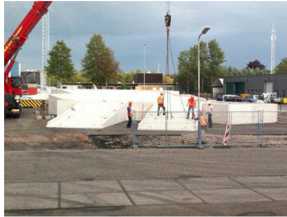
aanleg afvalbrengstation Leerdam
