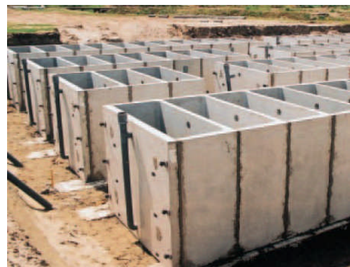
keldergraven bij aanleg
