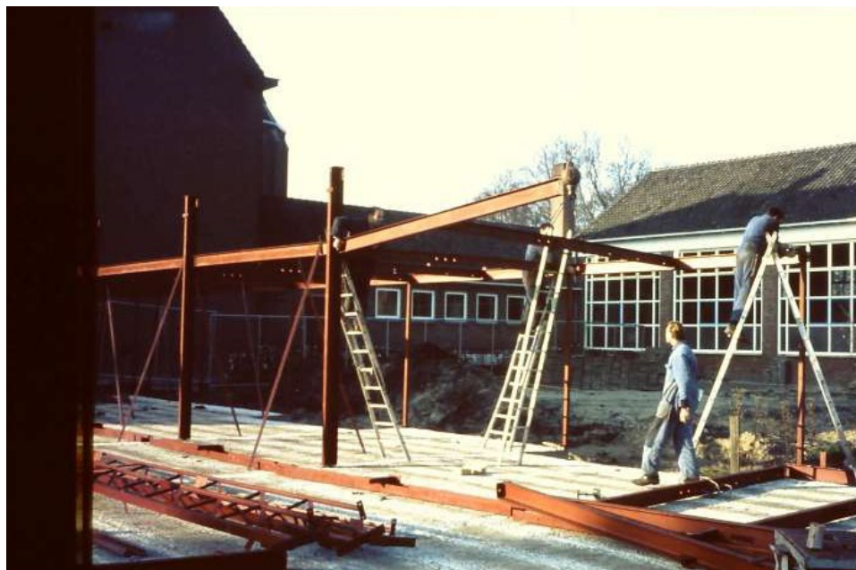
Aeresteijn in aanbouw
